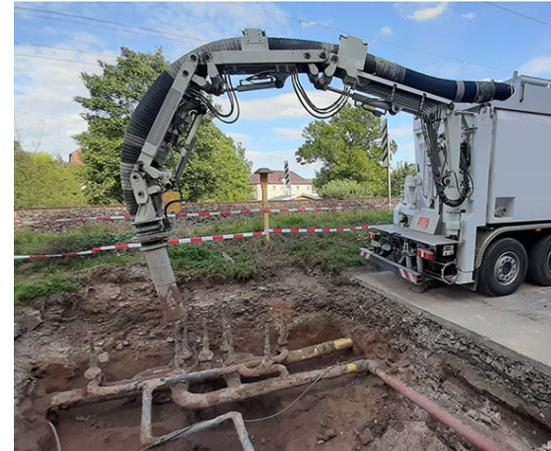
**Beschädigungsfreies Arbeiten:** Bei Tiefbau- und Erdarbeiten besteht stets ein hohes Beschädigungsrisiko, denn Rohre, Leitungen und Wurzeln verlaufen nicht immer dort, wo sie erwartet werden. Damit diese Arbeiten kein Glücksspiel bleiben, ist der Saugbagger die perfekte Lösung. Feinfühlig und ohne Beschädigungen legt er das Erdreich frei. Zudem kann er dicht an Gebäuden eingesetzt werden.
