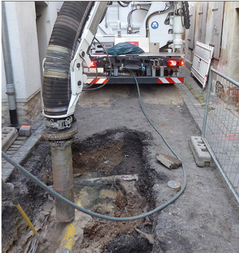
**Schnell am Einsatzort:** Saugbagger besitzen eine Straßenzulassung und benötigen keine Transportgenehmigung. Mit einer Höhe von unter 4 m, einer Breite von rund 2,5 m und einer Länge zwischen 7 und 10 m sind sie im Handumdrehen auf der Baustelle und aufgrund geringer Rüstzeiten umgehend einsatzbereit.
