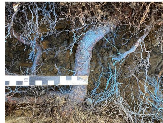
**Perfektes Ergebnis:** Für die schonende Freilegung von größeren verwurzelten Flächen ist ein Saugbagger unabdingbar und selbst an unzugänglichen Stellen und in Hanglage befreit der er Wurzeln schonend vom Erdreich. Nach dem Saugbaggereinsatz verbleiben die Wurzelstrukturen in allen Dimensionen nahezu unbeschadet. Zu Folgekosten – etwa aufgrund einer Neube-pflanzung – kommt es nicht.
